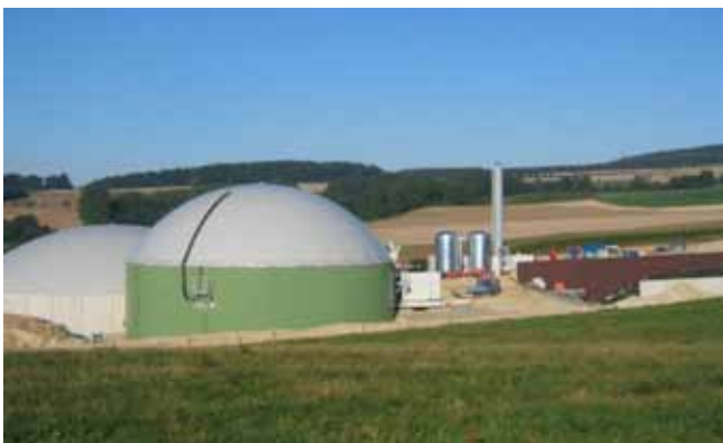
Figuur 6: voorbeeld van een conventioneel geroerde reactor (Bron: IZNE, 2008, zie Annex II)
