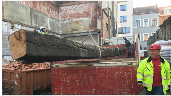
Het renovatieproject van de site Hageltoren in Brussel: recuperatie van houten balken bij de inrichting van de publieke ruimte. Foto's: opalis.be
